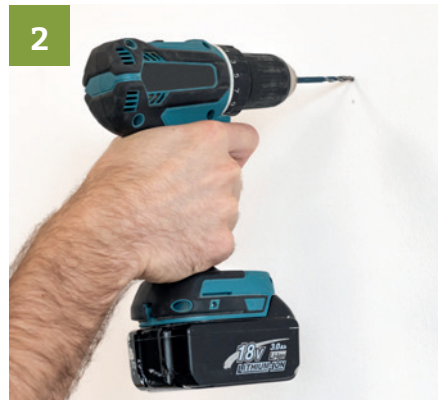
2 Löcher bohren, \varnothing 5mm
